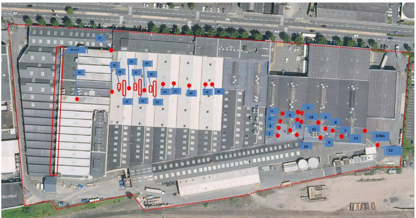
Figure 1 : localisation des rejets en toiture
